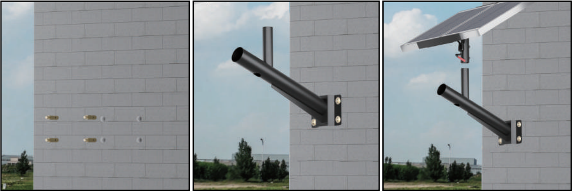
④ Praticare dei fori nella parete contro il telaio del palo ⑤ Avvitare il palo alla parete ⑥ Fissare il pannello solare al braccio di montaggio e fissarlo con le viti
