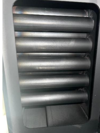
Figure 36 - Passage des fumées dans les échangeurs (vue sans pare-flamme)
