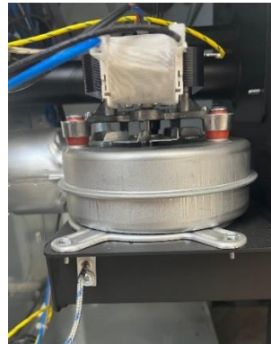
Figure 39 - Nettoyage du moteur de fumées
