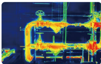
inspección de tuberías
