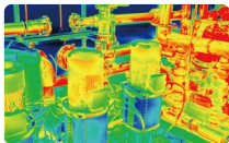
ispezione del gas e dell'elettricità
