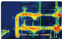
inspection de tuyauterie
