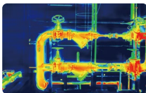
ispezione delle condotte
